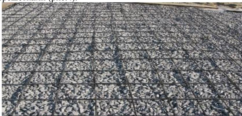
Рис. 4. Армирование композитными георешетками в железнодорожном строительстве
