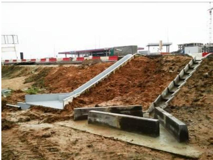
Рис. 3. Лотки водоотводящие из конструкционных композитных материалов
