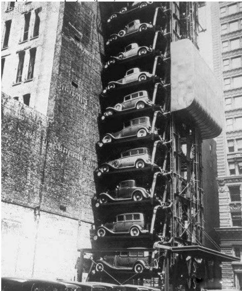
Рис. 1. Роторная парковка “чертово колесо”
