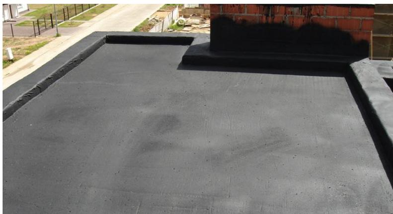
Рис. 10. Напыляемая кровля («жидкая резина»)
